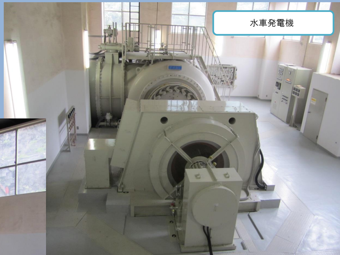
八戸川第二発電所外観
